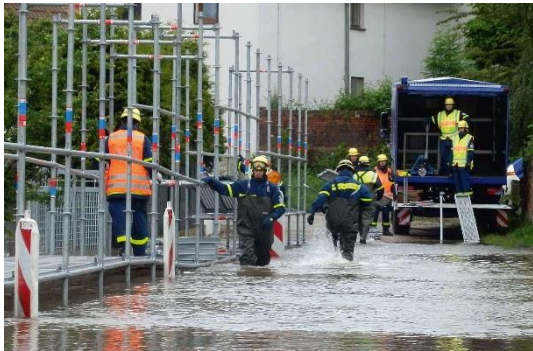
Aufbau Hochwasserlaufsteg 2013
